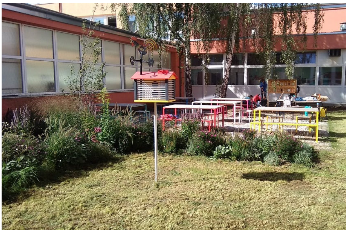
Vnitřní atrium po rekonstrukci – podzim 2019
