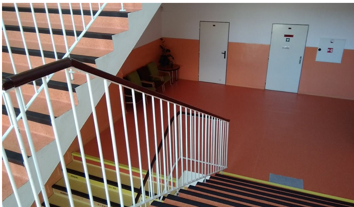
Chodby II. stupně
