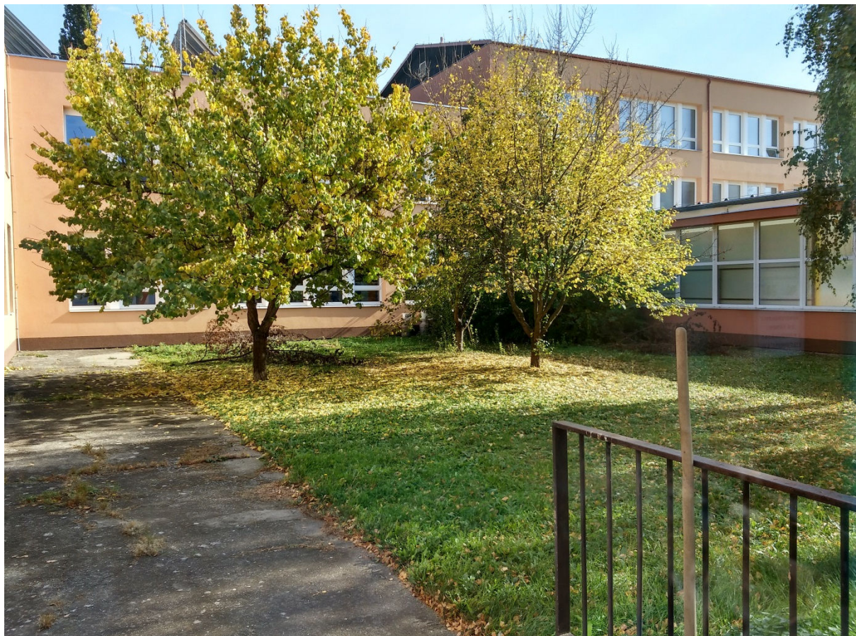
Vnitřní atrium před rekonstrukcí – podzim 2018
