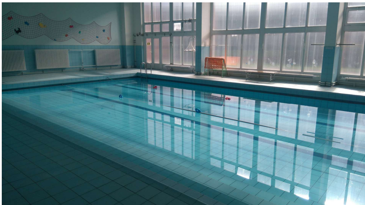
Školní bazén před rekonstrukcí
